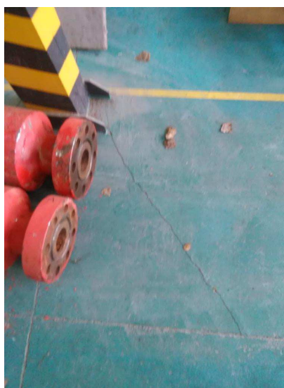
Fot. 5,6,7,8,9. Widok pęknięć i uszkodzeń posadzki
