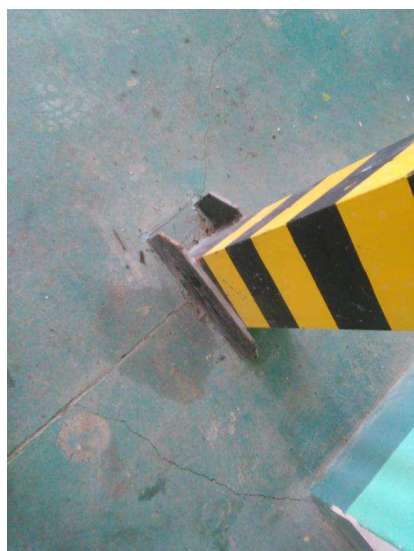
Fot. 5,6,7,8,9. Widok pęknięć i uszkodzeń posadzki
